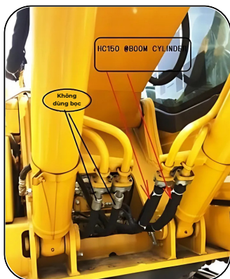
(Lắp đặt bọc bảo vệ HC150 lên đường ống cần)
