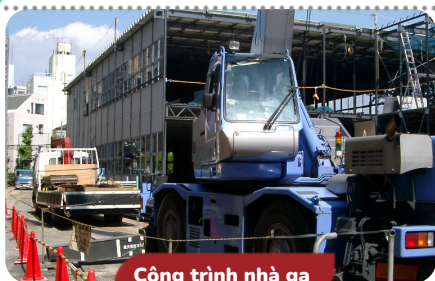
Công trình nhà ga
