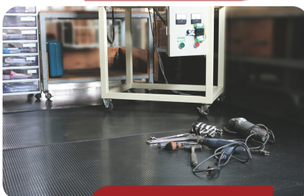
Sàn làm việc trong nhà máy
